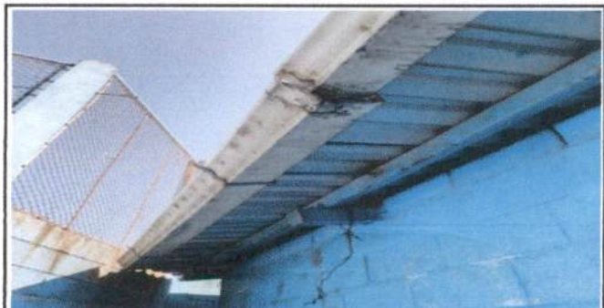
Foto 6: Cambio de canales de aguas pluviales y bajadas de agua.
