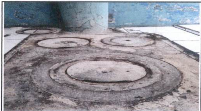
Foto 4: Cambio de plancha de cocina.
