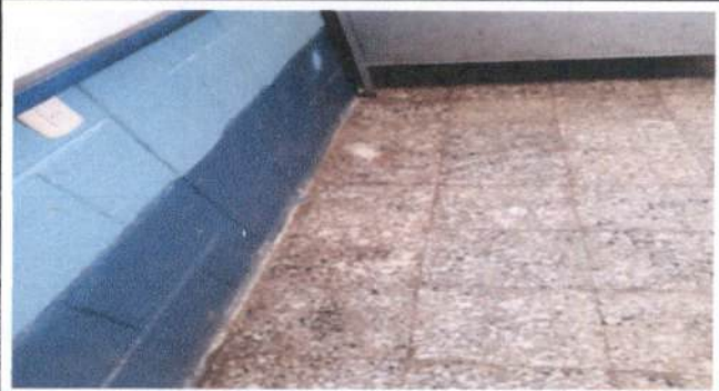
Foto 2: Reparacion de piso de granito a ceramico.
