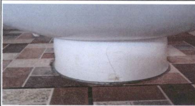
Foto 3: Cambio de tasas por estar quebrada o rajada.
